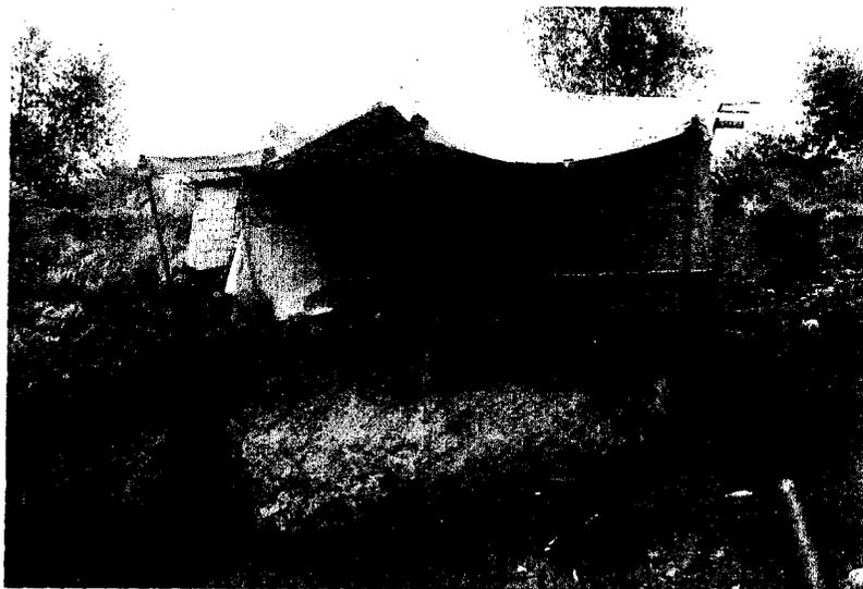
La vivienda esta construida con muros de block y castillos, con techo de lámina de cartón y una parte con lona plásticadicha vivienda no cuenta con cimentación tiene una dimensión de 20 m2 aproximadamente.
